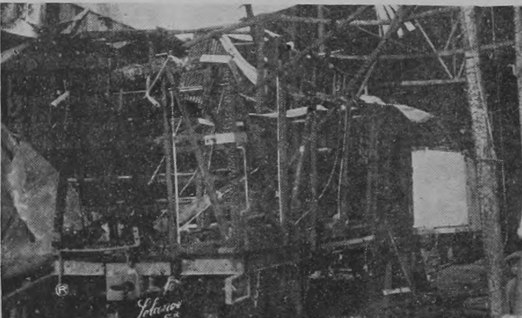
Vagón destruido por las llamas, uno de los construidos por los trabajadores de los talleres. (FOTO SOLANOV).
