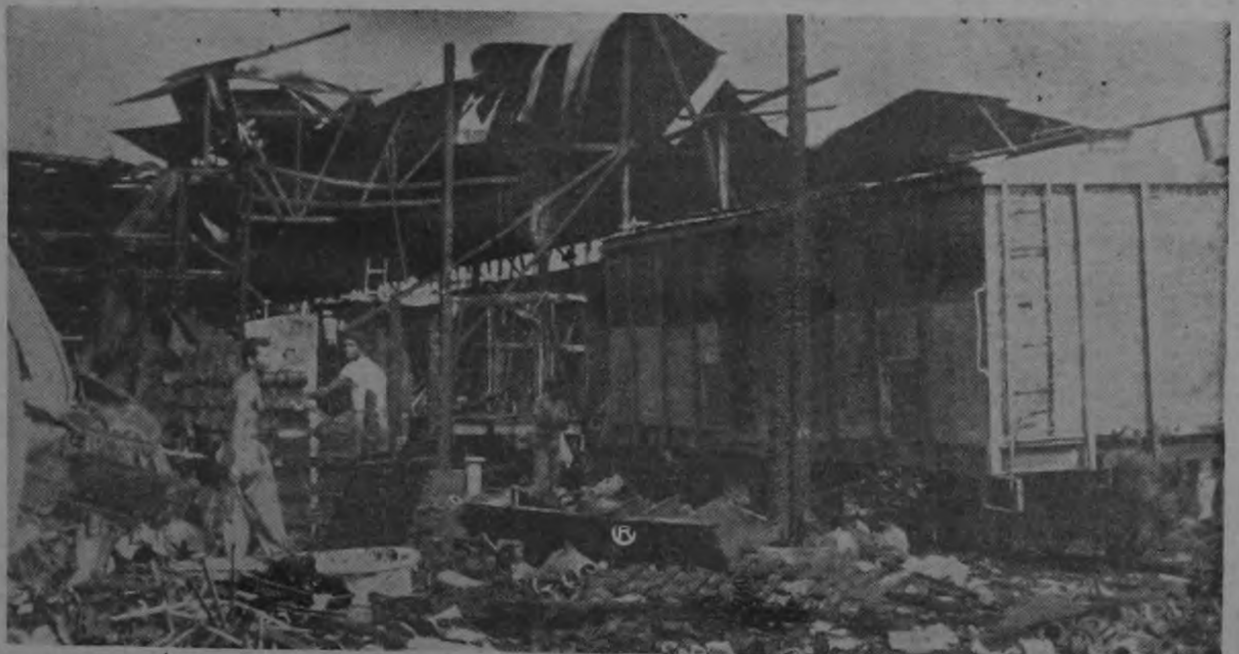
Uno de los aspectos de la destrucción de los talleres de la Northern en Limón que se desató ayer en la mañana. Aunque inicialmente se atribuye el siniestro a efectos de las chispas producidas por tra-
