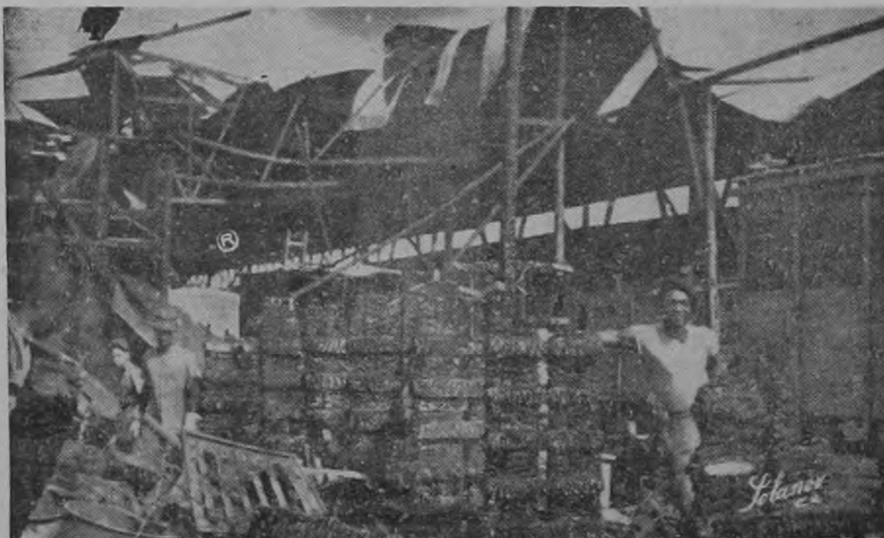
Solamente ruinas quedaron del amplio galerón que servía de taller de la Compañía ferroviaria que implica total construcción. (FOTO SOLANOV).
